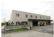
岐阜導管工事センター
