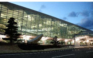
中部国際空港旅客ターミナル
