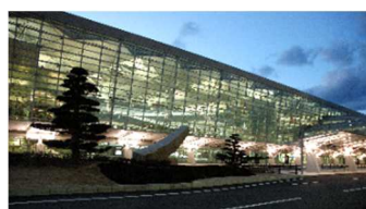
中部国際空港旅客ターミナル
