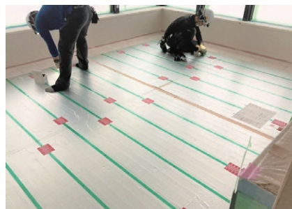
住宅設備工事
