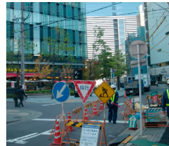
名古屋市中村区名駅 リニア建設に伴う入替工事
