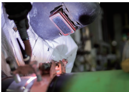
ガス幹線工事
