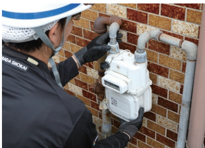
ガスメーター取替工事
