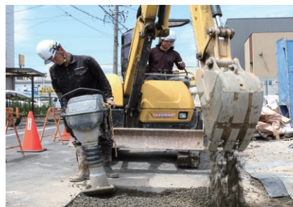
ガス供給管工事
