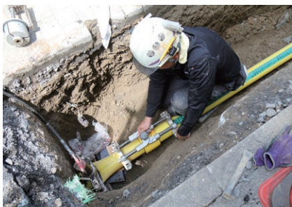
ガス導管工事
